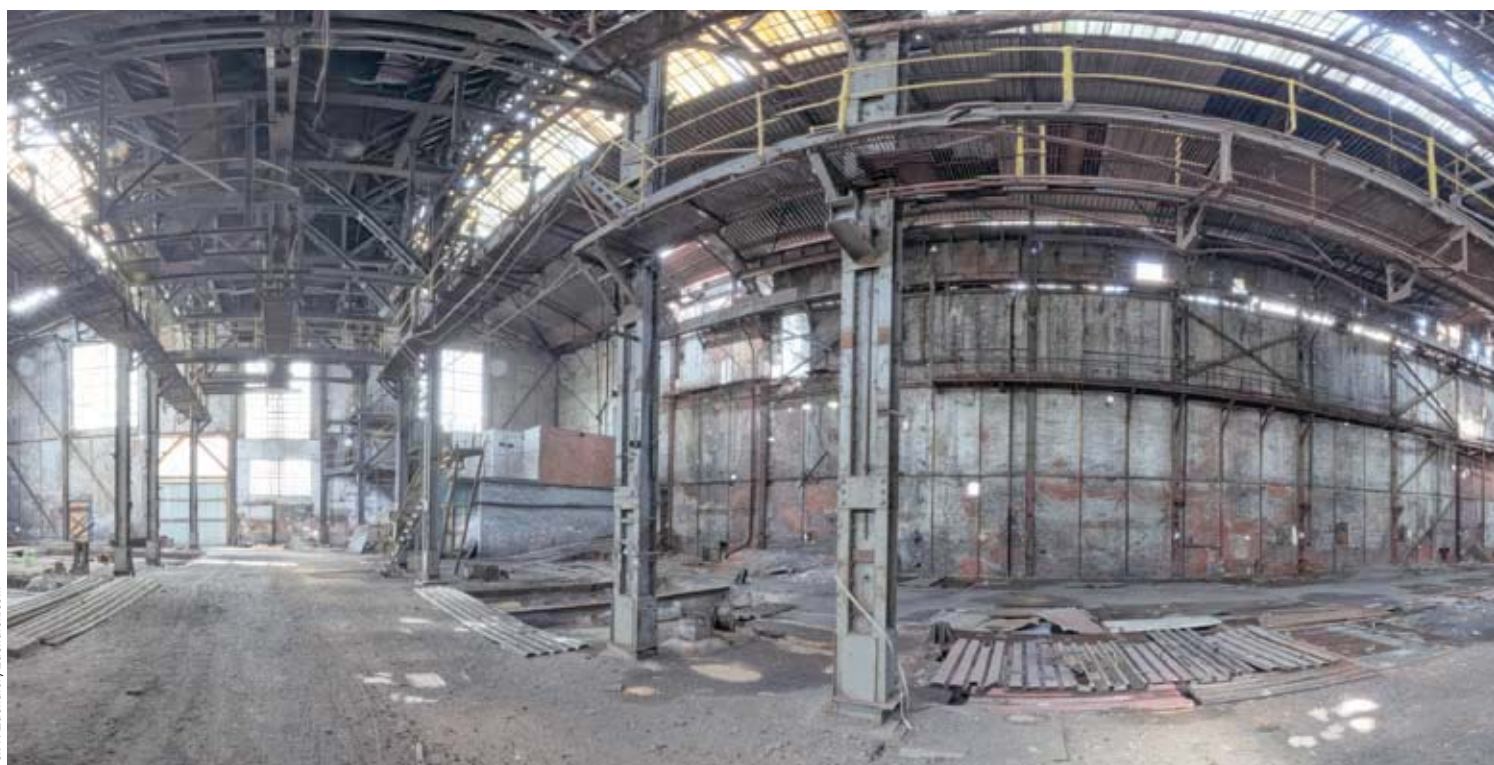
Wnętrze opuszczonej hali Elektrowni Powisłe – stan dzisiejszy
