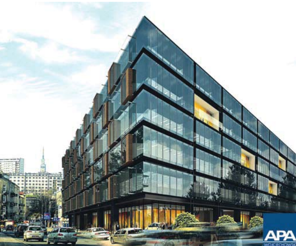
Siedmiokondygnacyjny budynek w pierzei ulicy Zajęcej
