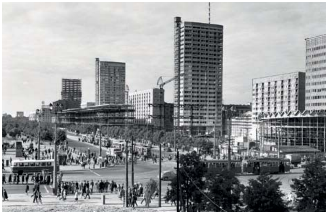
Teren budowy Ściany Wschodniej przy ulicy Marszałkowskiej, 1964-1966
