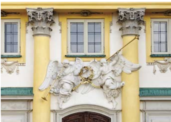
Elewacja zachodnia korpusu głównego, famy, l. 1681-83
