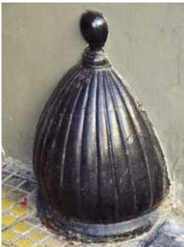
Il. 9. Odbój kopulasty, z parasolowym kanelowaniem i girlandą u podstawy, w kamienicy przy ul. Lwowskiej 13 (1911-12)
