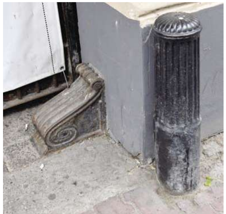
Il. 5. Odbój konsolowy, esowo-wolutowy, prostokątny w przekroju poziomym, w przejeździe kamienicy przy ul. Zgoda 1 (1874-75) i przed elewacją pachołek kanelowany
