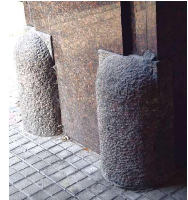
Il. 16. Odboje kamienne w kamienicy Zarządu Zakładów Gazowych przy ul. Kredytowej 3 (1905-07)
