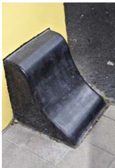
Il. 4. Odbój wspornikowy, niezdobiony, prostokątny w przekroju poziomym, trójkątny w profilu pionowym, w kamienicy przy ul. Kępczej 6 (ok. 1910)
