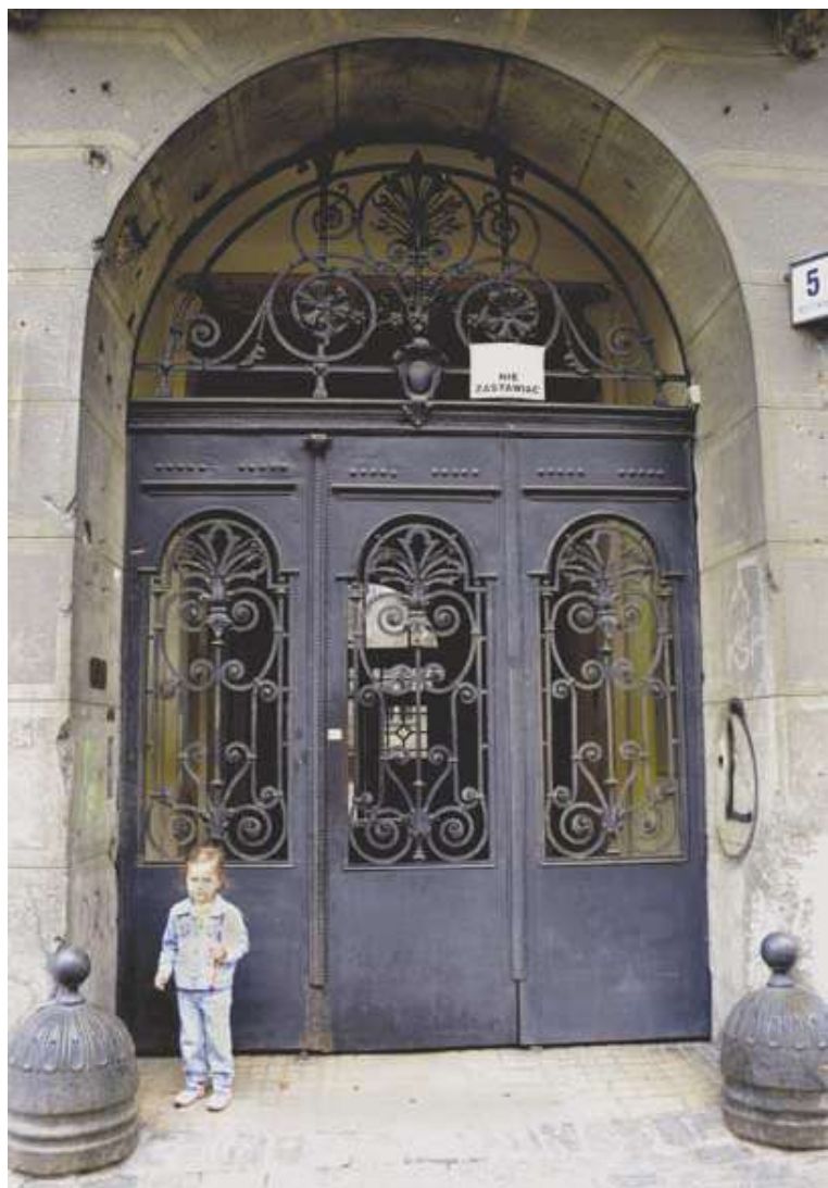
Il. 1. Odboje kopulaste z dekoracyjnym kołnierzem złożonym z przetworzonych motywów antycznego ornamentu i z sygnaturą (zatartą) FIDOR , umieszczone w narożach zewnętrznych przejazdu bramnego kamienicy przy ul. Mokotowskiej 5
