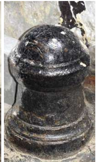
Il. 14. Odbój słupkowy, kolisty w przekroju poziomym, w kamienicy przy ul. Targowej 41
