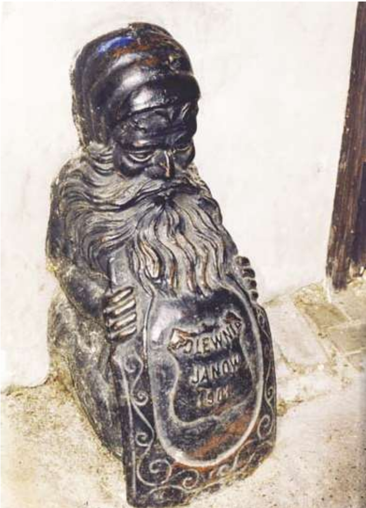
Il. 6. Odbój w formie krasnala, z napisem na tarczy ODLEWNIA JANÓW 1901 , w przejeździe bramnym kamienicy przy ul. Mokotowskiej 57 (1901)
