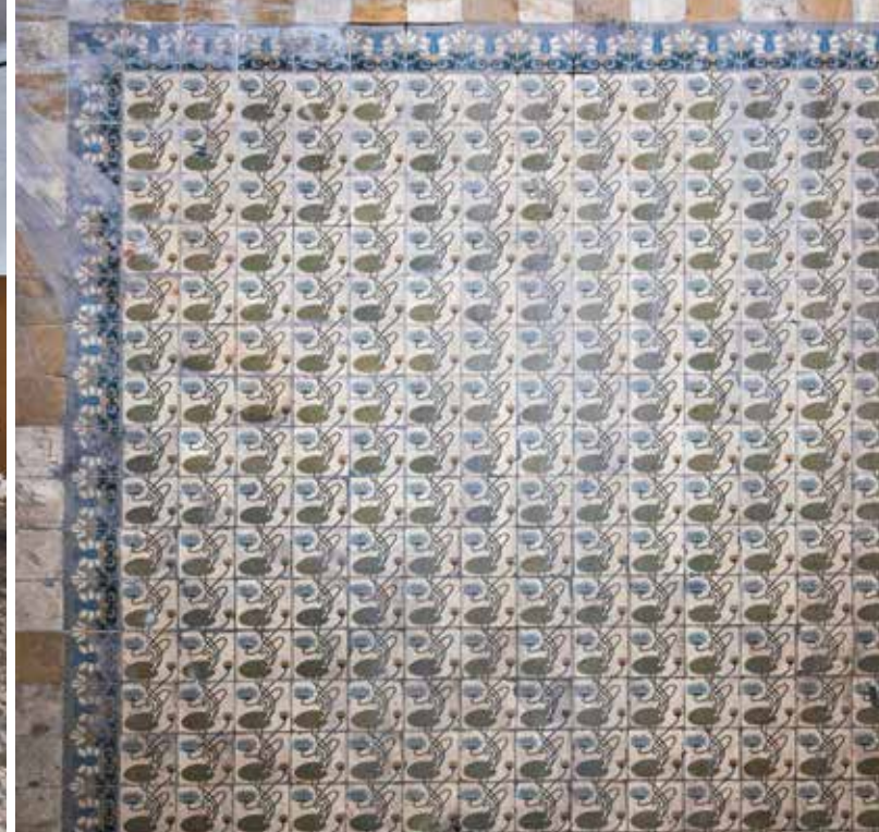
Pomieszczenie w piwnicy domu przy ul. Elektoralnej 11 wyłożone (wtórnie?) płytkami z motywem nenufarów
