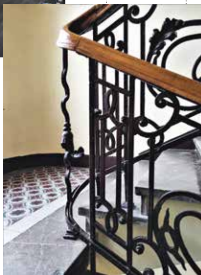
Wystrój elewacji kamienicy przy ul. Elektoralnej 11 skuto po wojnie, przetrwał natomiast m.in. detal głównej klatki schodowej
