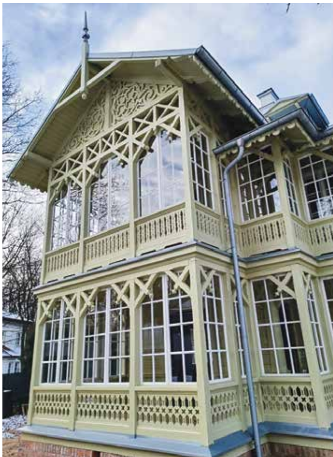
Willa przy ul. Fletniowej 2 na Białoleścu, wyremontowana z udziałem dotacji m.st. Warszawy
