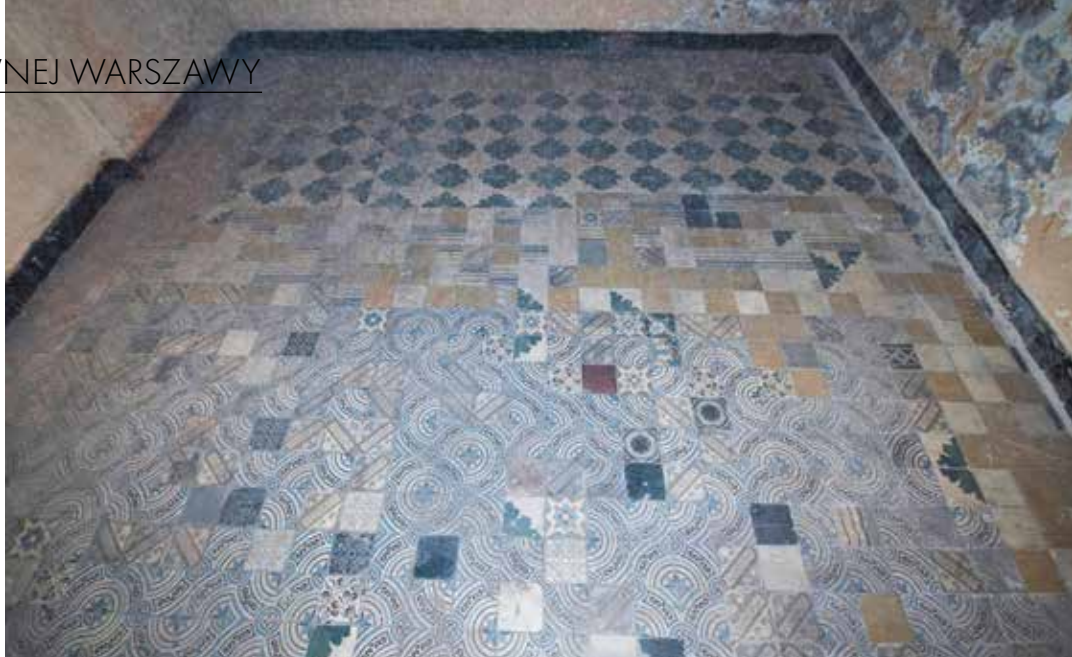
Pomieszczenie w piwnicy domu przy ul. Elektoralfnej 11 wyłożone (wtórnie?) od strony wejścia płytkami o kilkunastu różnych wzorach, a pod przeciwną ścianą – płytkami z motywem liści klonu, znanymi m.in. z holu d. Domu Bankowego W. Landaua przy ul. Senatorskiej 38
