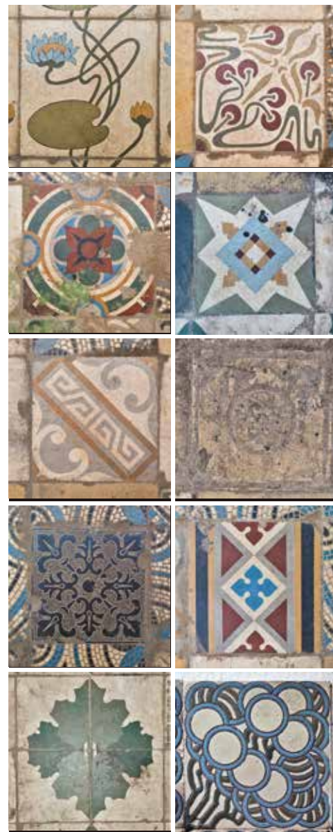
Przykłady płytek posadzkowych w piwnicy domu przy ul. Elektoralfnej 11
