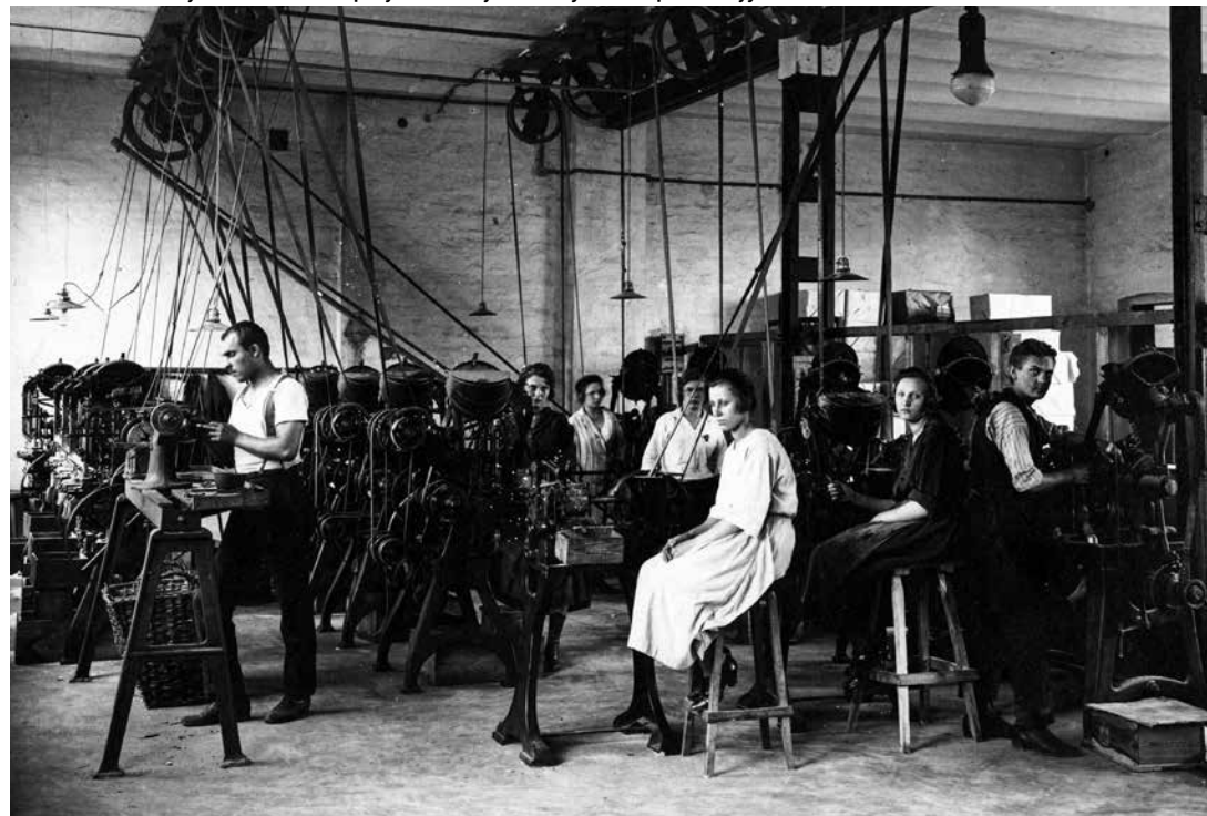
Warszawska Fabryka Guzików SA przy ul. Radzywińskiej 7, hala produkcyjna
