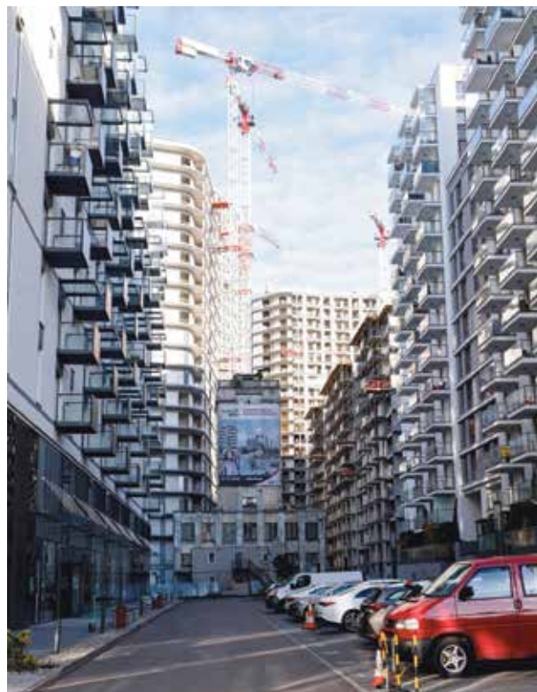
Wciśnięta między zabudowę wieża ciśnień z l. 1931-1936 służy... jako nośnik reklam
