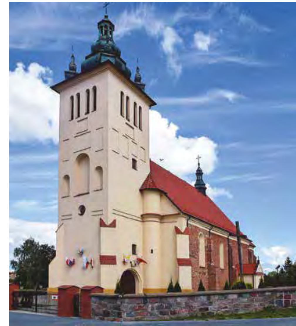
Krzynowłoga Mała, kościół parafialny, XVI-XVII w., widok ogólny od strony południowo-zachodniej
