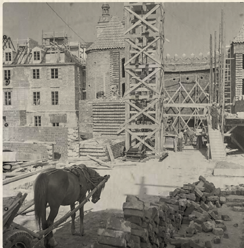
Rekonstrukcja Barbakanu w 1964 r.
