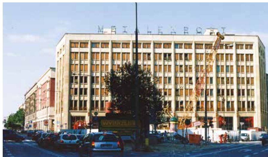
Budynek „Metalexportu” w 2004 r.
