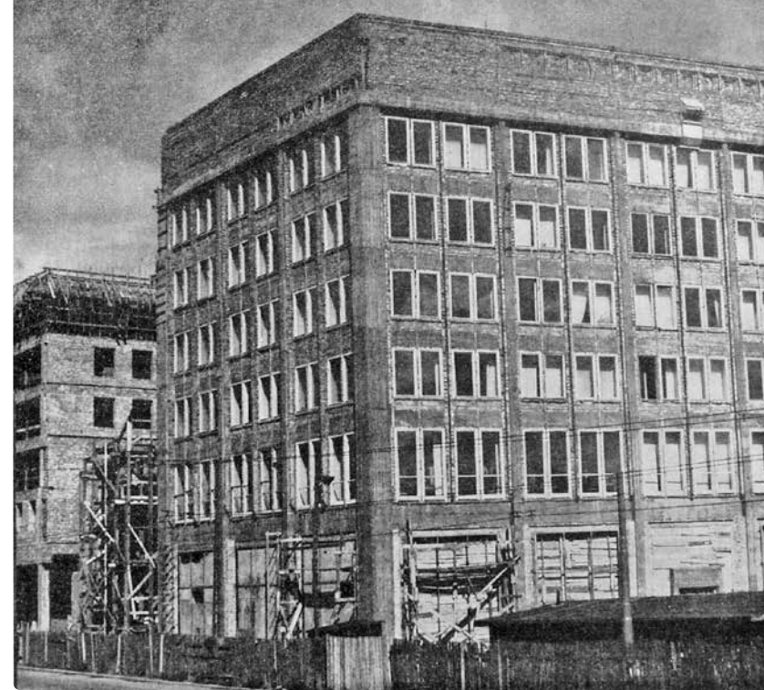
Biurowiec „Metalexportu” – stan budowy we wrześniu 1952 r., za: B. Garliński, Architektura polska 1950-1951 , Warszawa 1953
