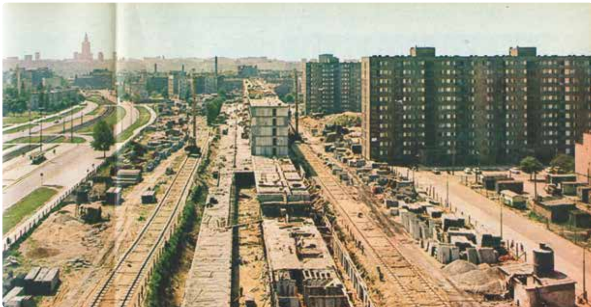
Budowa bloku przy ul. Kijowskiej 11, „Stolica”, 1972, nr 29
