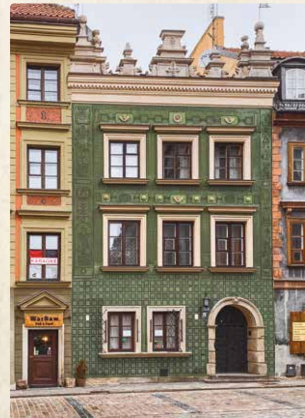
Kamienica pod Chrystusem przy ul. Wąski Dunaj 8
