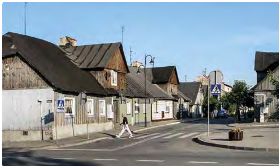
Mogielnica, rynek, widok pierzei z drewnianymi domami niegdyś podcieniowymi z lat 40.-70. XVIII w.
