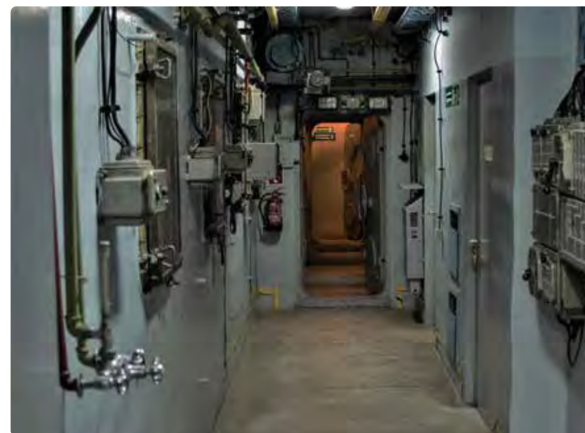
Wejście do schronu Alfa, stan współczesny
