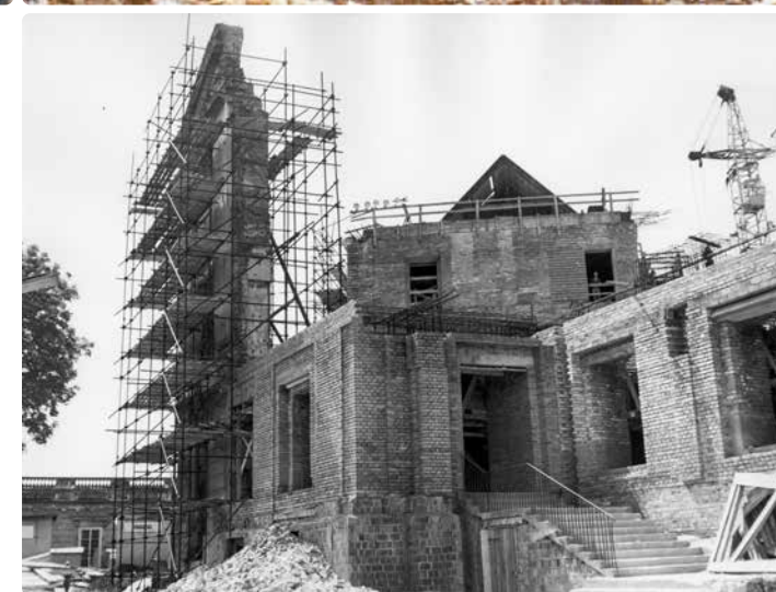
Przygotowania do operacji prostowania zachowanej ściany, 1974 r.
