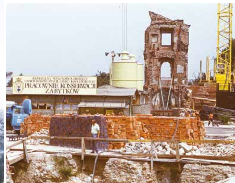
Początek prac budowlanych, w tle widoczny oryginalny fragment muru, 1971 r., fot. J. Muszyński
