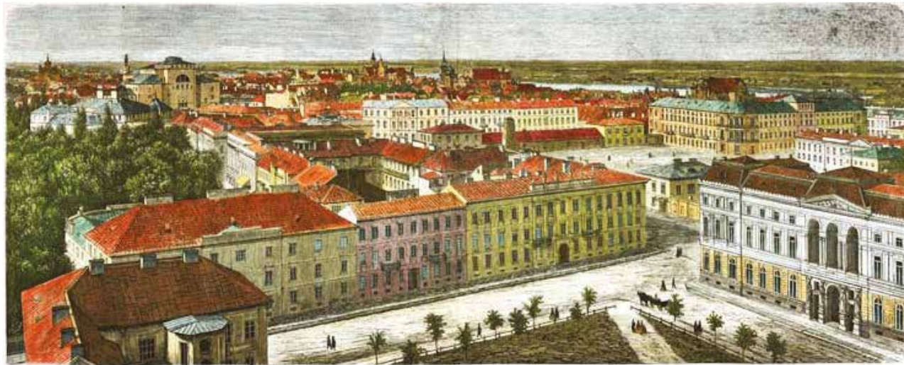
Ulica Królewska, widok z latarni kościoła pw. Świętej Trójcy
