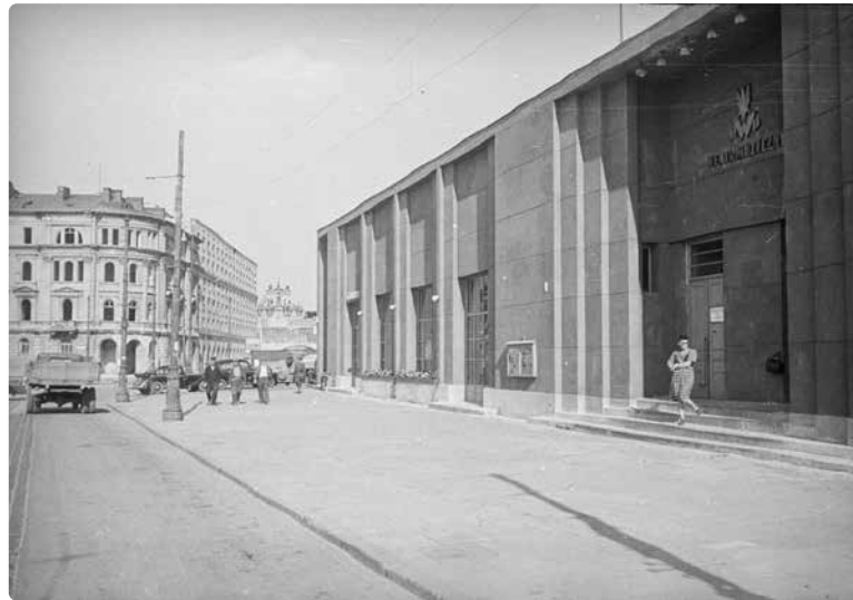
Budynek dawnego IPS, ok. 1947 r.
