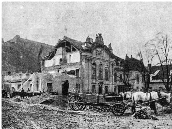
Pałac Bielińskiego tuż przed rozbiórką i rozbiórka obiektu, l. 90. XIX w.
