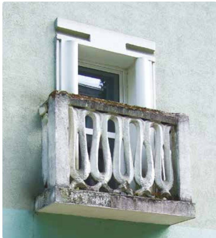
Balkon jednego z bloków mieszkalnych
