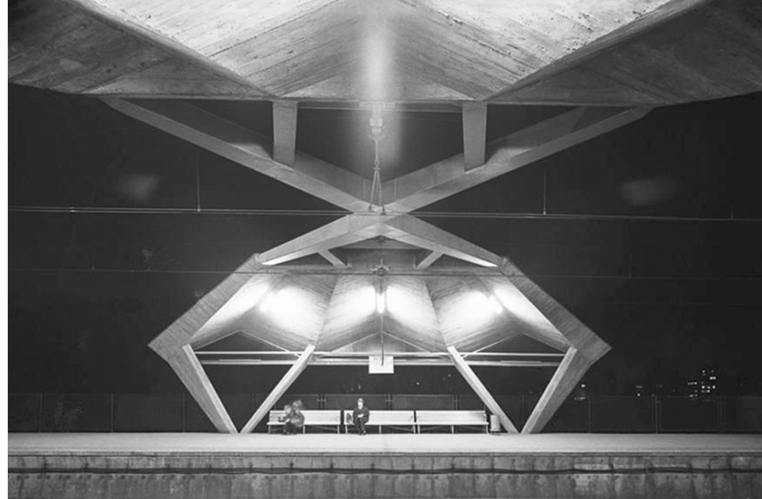
Stacja PKP Warszawa-Powisłe, A. Romanowicz, P. Szymaniak, l. 1954-1963, fot. Zbyszko Siemaszko
