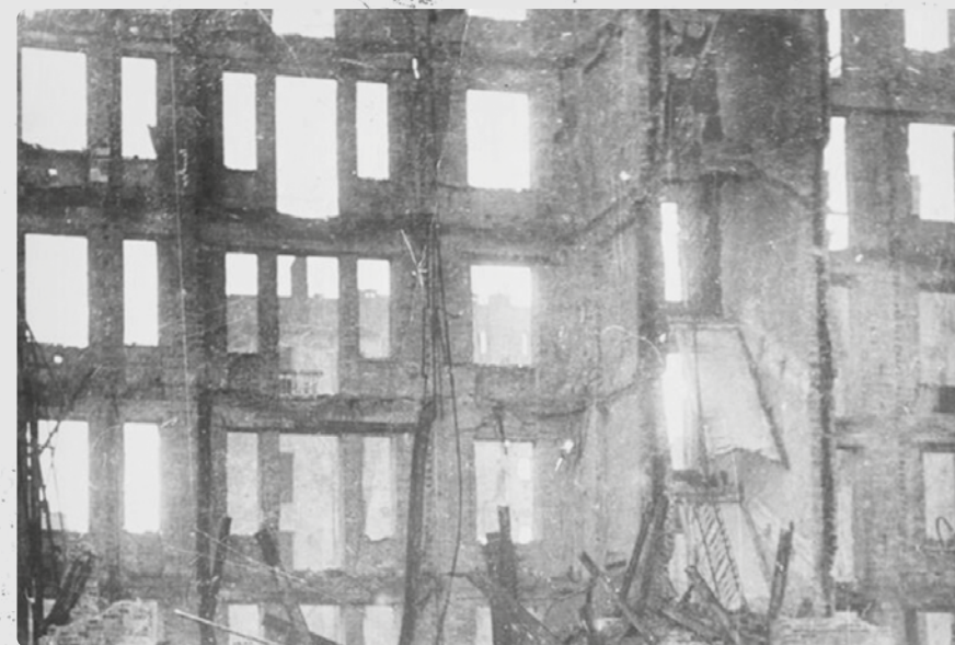
Wypalone mury kamienicy, 1945 r., fot. Zofia Chomętowska
