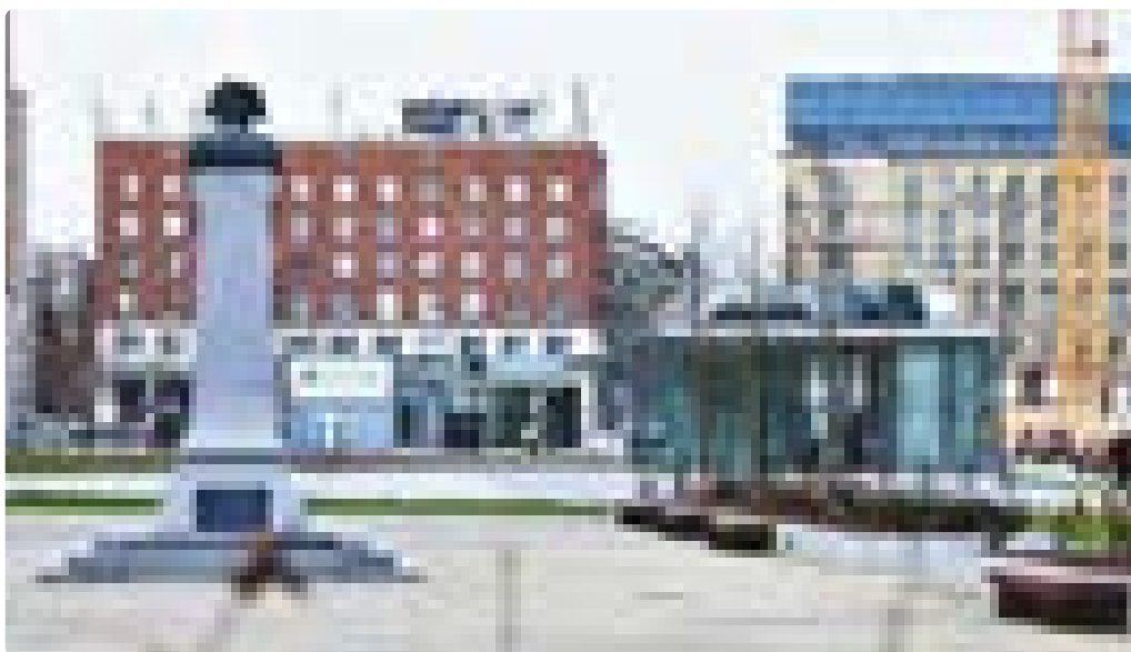
Plac Powstańców Warszawy w nowej odsłonie
