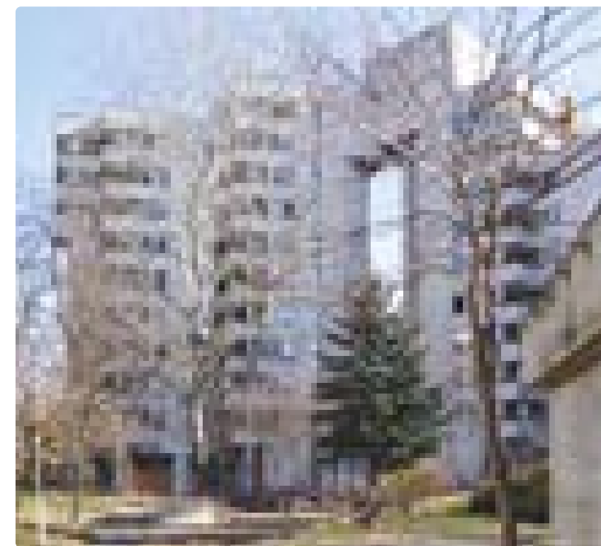
Szpiegowo, ul. Sobieskiego 100, wnętrze osiedla
