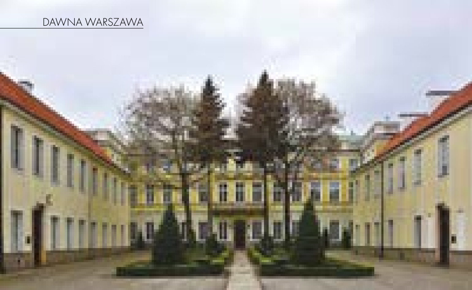
Pałac Borchów przy ul. Miodowej 17/19, 2017 r.
