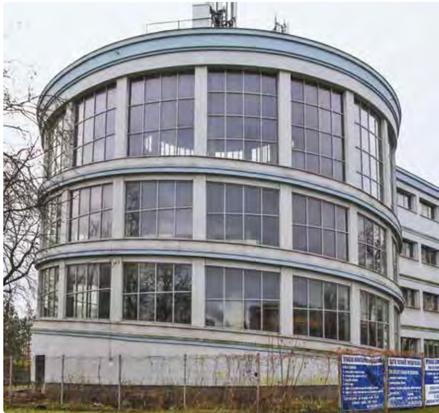
Zabytkowy budynek garażu Stołecznej Kolumny Transportu Sanitarnego przy ulicy Woronicza
