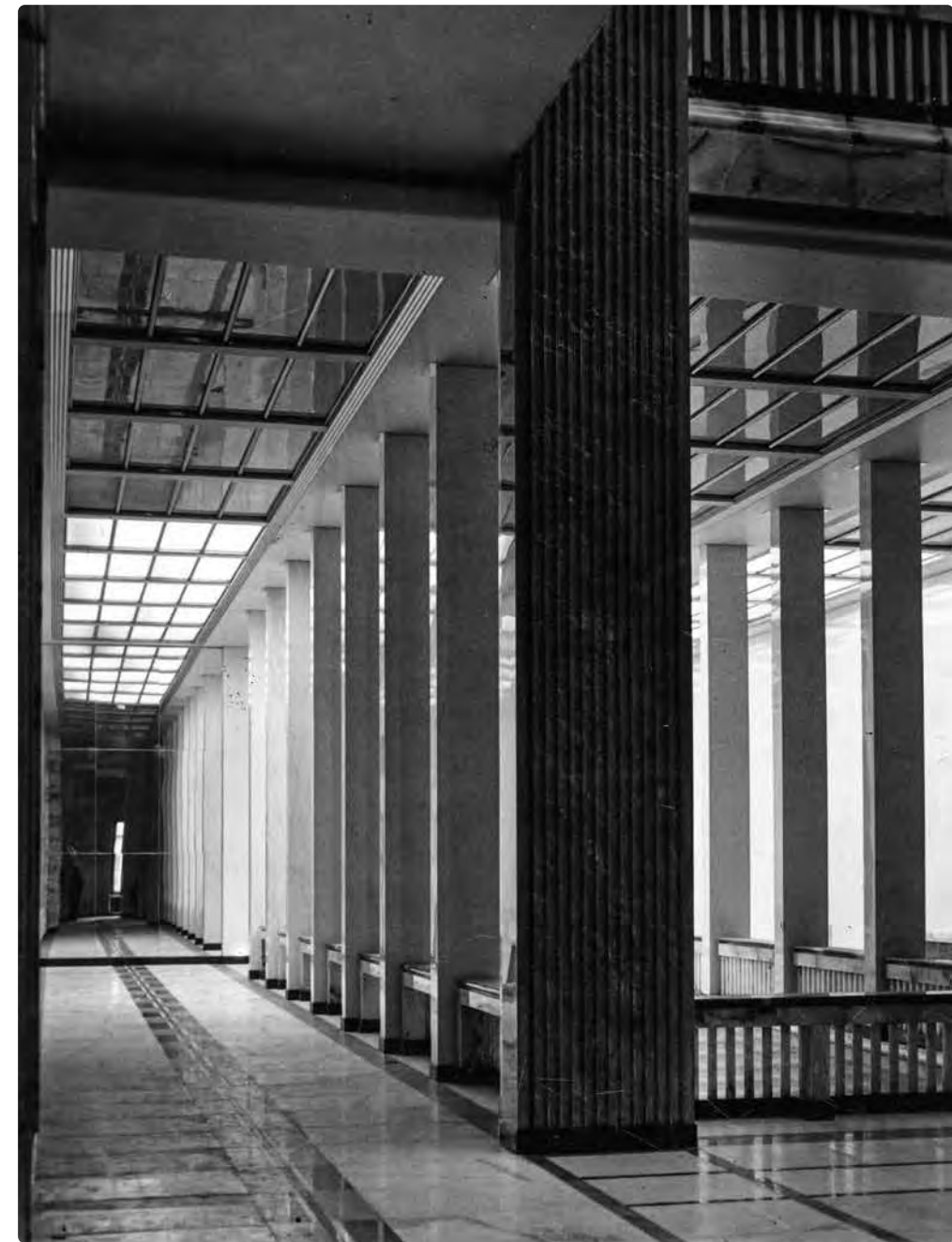
Widok na hol pierwszego piętra i klatkę schodową
