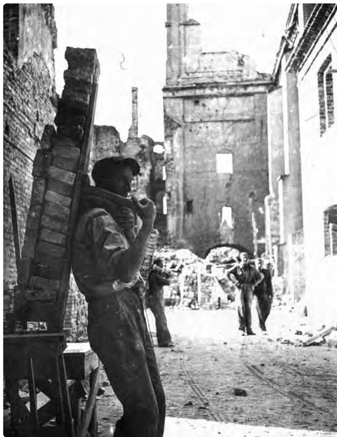
Ulica Dziekania, prace przy odbudowie w toku
