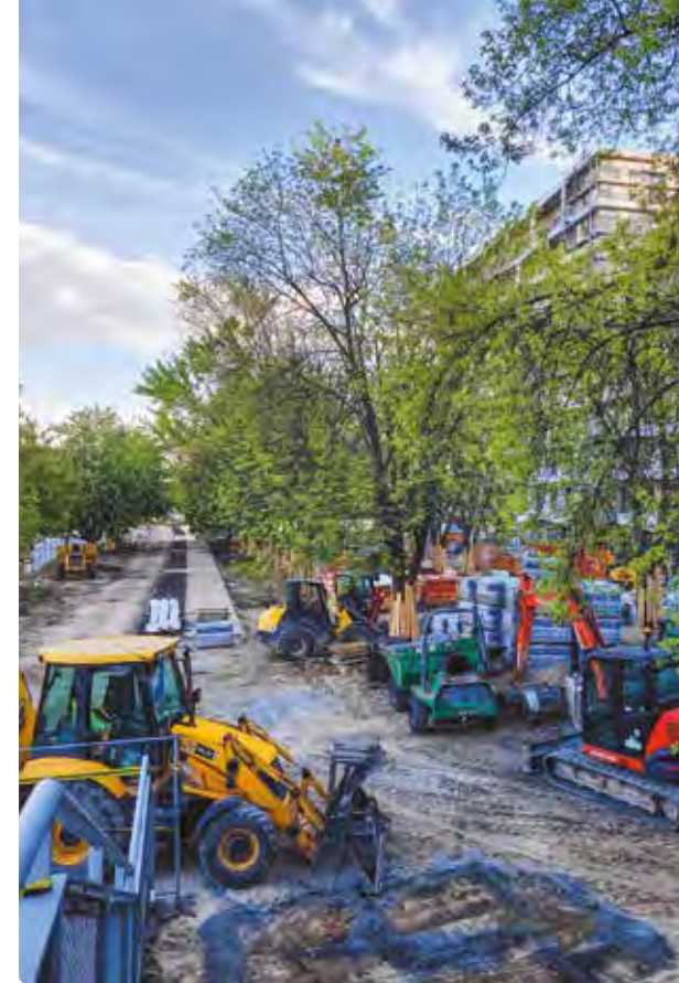
▲ Trwa budowa pierwszego fragmentu parku wzdłuż ulicy Wołoskiej, tuż obok kompleksu mieszkalnego firmy Archicom
