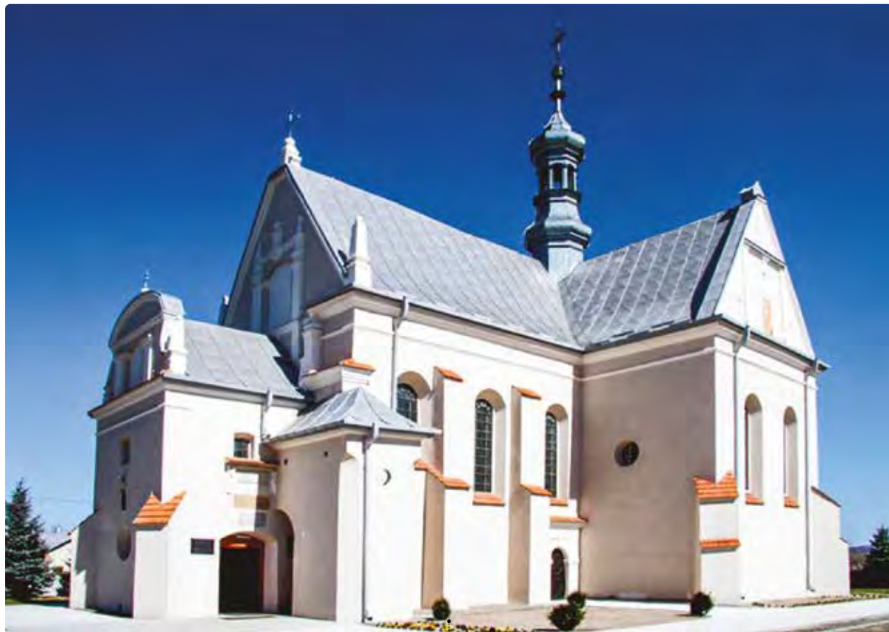
▲ Solec nad Wisłą, kościół parafialny pw. Wniebowzięcia NMP, widok ogólny od strony południowo-zachodniej, XIV – 1. poł. XVII w.
