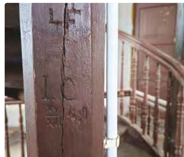
◀ Wnętrze wieży, na pierwszym planie znaki ciesielskie na elementach konstrukcyjnych, w tle drzwi prowadzące na balkony
