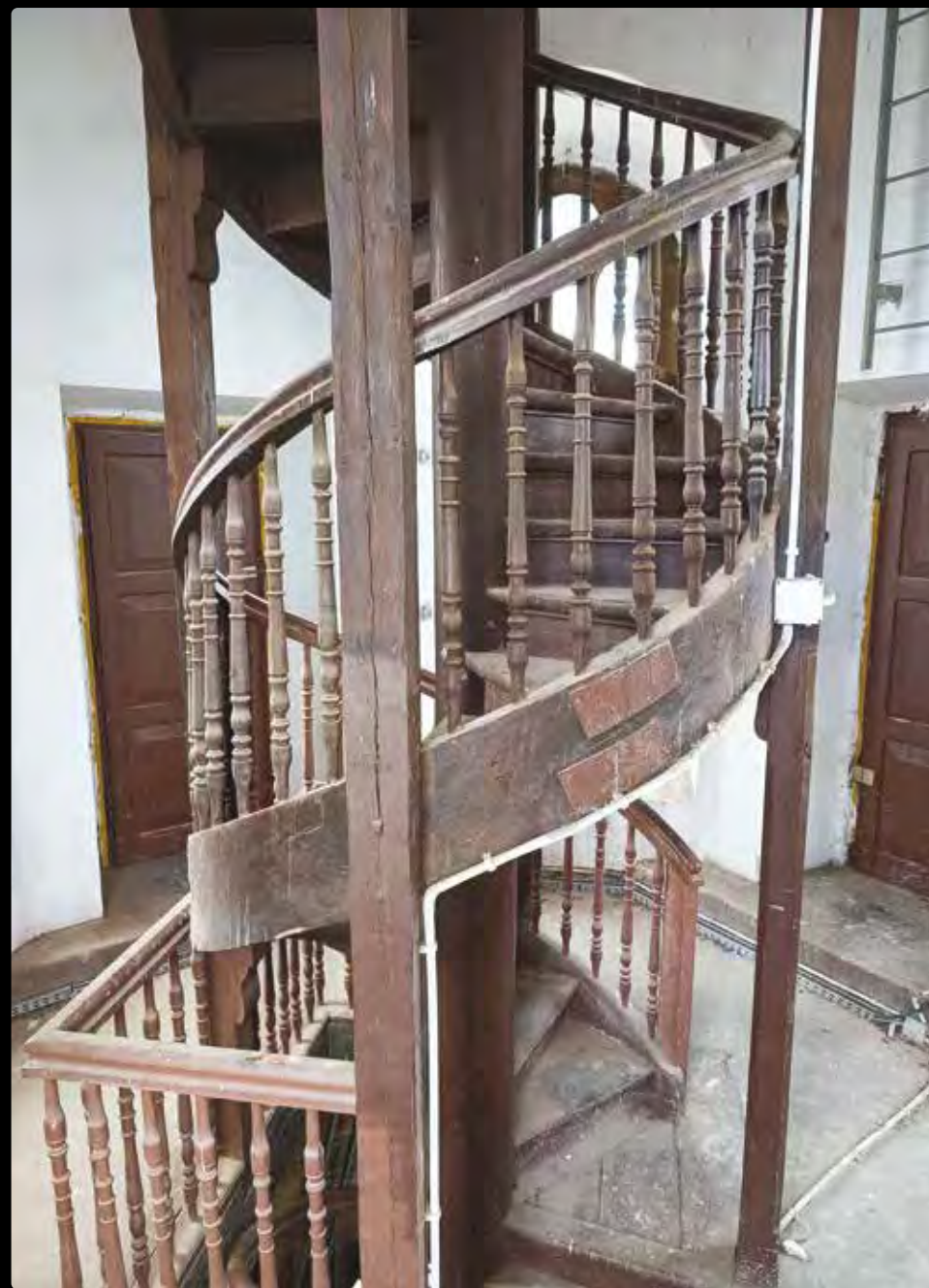
Wnętrze wieży: schody i drzwi prowadzące na balkony ▼
