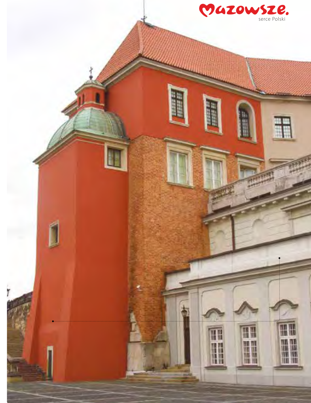
▲ Warszawa, Zamek Królewski, tzw. Wieża Grodzka
