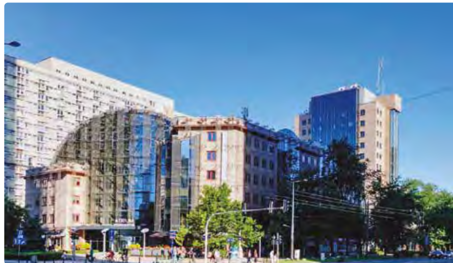
Atrium Business Center, budynek dziś już nie istnieje
