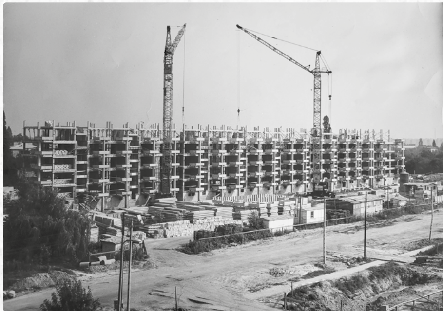
Budowa osiedla Służew nad Dolinką w systemie ramy H
