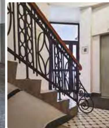
Przejazd bramny, podwórze studnia i wnętrze klatki schodowej kamienicy przy ul. Hożej 62
