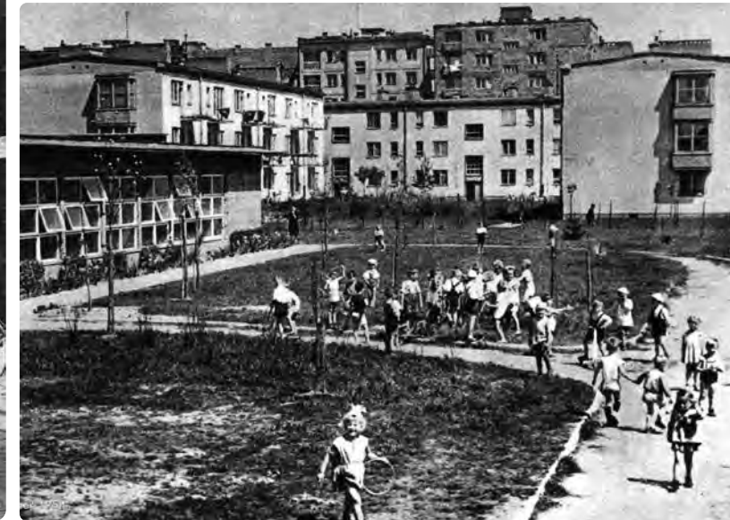
Przedszkole przy ul. Dąbrowskiego, 1953–1954 r.
