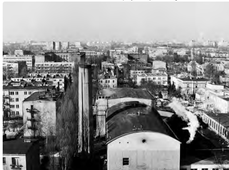
Kotłownia WSM Mokotów, widok z wieżowca przy ul. Dąbrowskiego 86, 1968 r.
